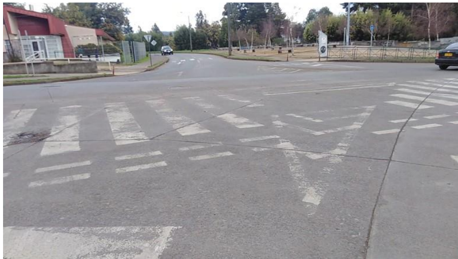
FIGURA N° 3.4.1.4. Demarcación en mal estado.
